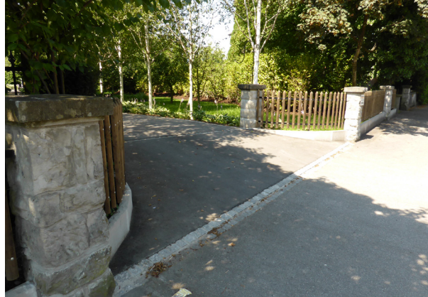
Der Hochwasserschutz dieser Einfahrt auf einem Privatgrundstück konnte mit einer 20 cm hohen Rampe realisiert werden.
